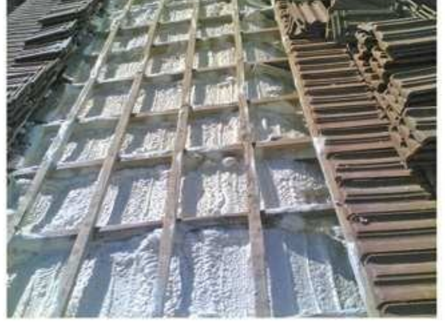
KİREMİT ALTI ÇATI UYGULAMASI
