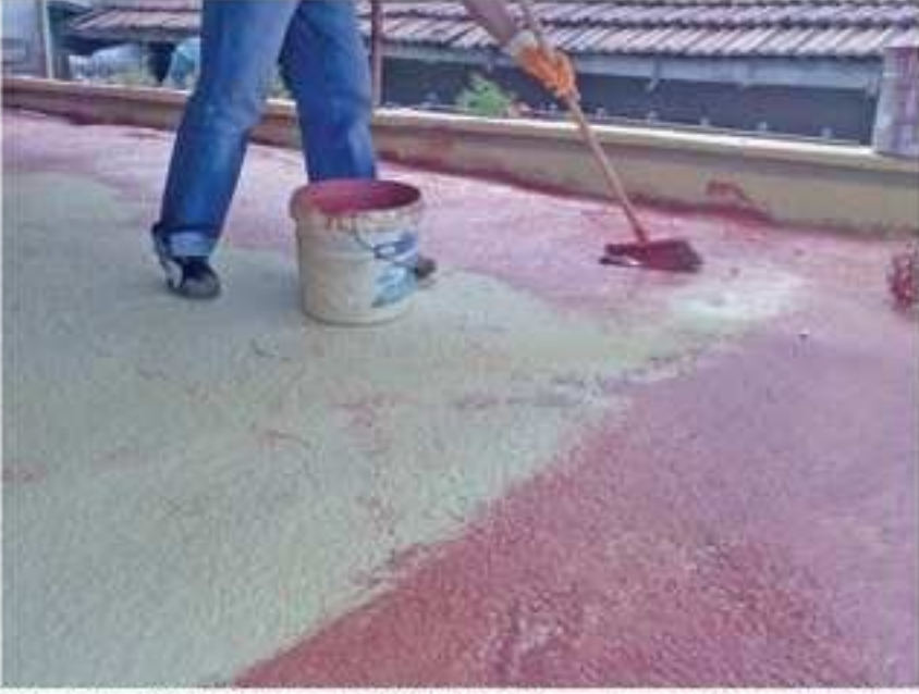
POLİÜRETANIN ÜZERİ UV KORUYUCU BOYA, ŞAP, MEMBRAN VEYA DERE ÇAKILI İLE ÖRTÜLEREK UZUN SÜRELİ KORUMA SAĞLANIR.
