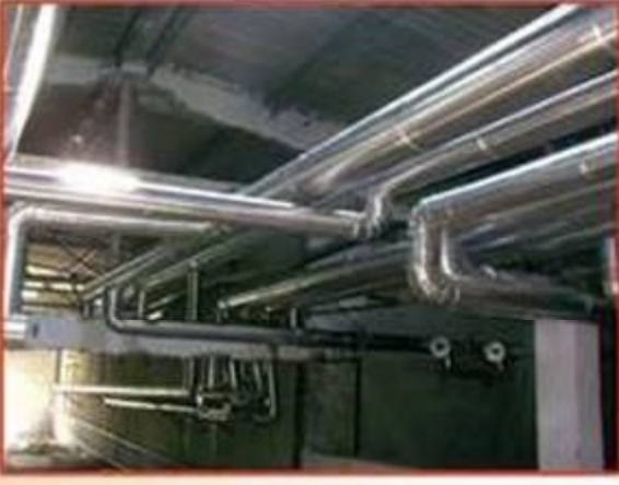
ISITMA VE SOĞUTMA TAŞIYICI BORU SİSTEMLERİNİN CEKETLEME İZOLASYONUNDA
