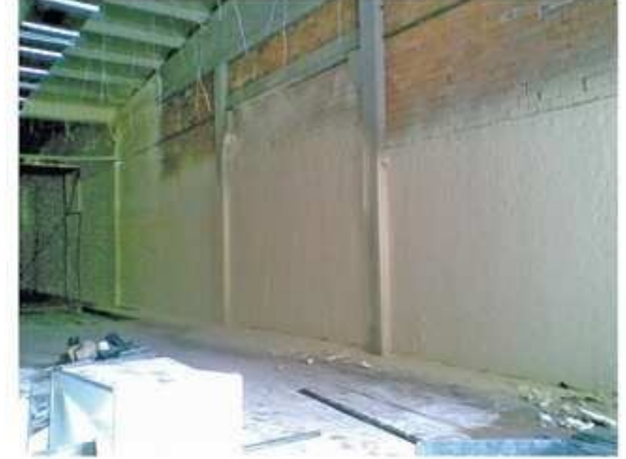
ENDÜSTRİYEL İŞLETMELERDE POLİÜRETAN PÜSKÜRTME İLE DUVAR UYGUMALASI YAPILIR
